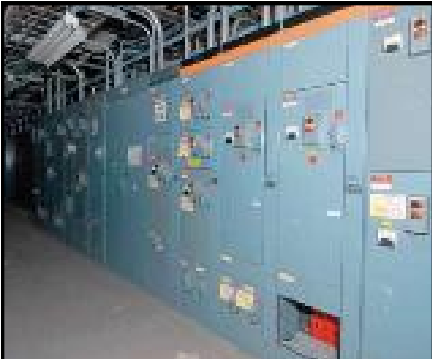
SQUARE D SWITCHGEAR
